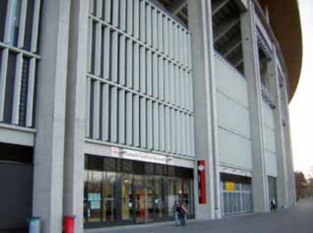
Commerzbank Arena / Eingang
